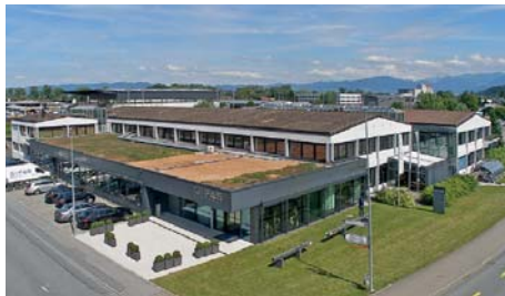
2018 – surface utile 8'500m 2 , 6 ème extension prévue
